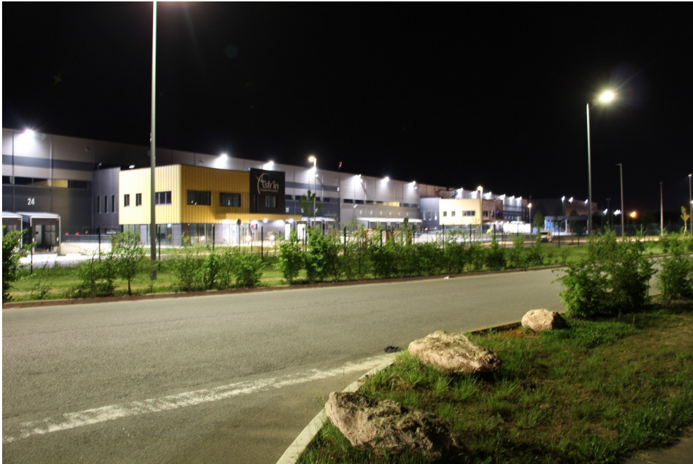
Autre entrepôt : éclairages du bâtiment, des quais et éclairage public sur la voie.
